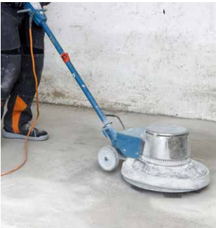
Boden abschleifen
