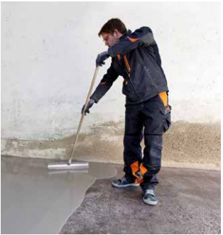
Beschichtung verteilen
