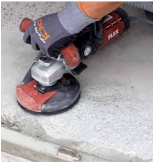
Ecken und Anschlüsse nacharbeiten
