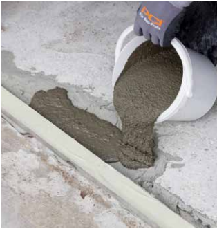
Einfahrtsschiene mit fließfähigem Mörtel hintergießen
