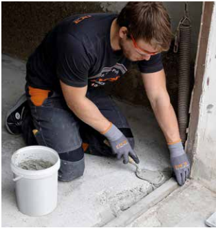
Alternativ mit Mörtel ausspachteln
