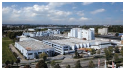
Werk Augsburg, Zentrale
