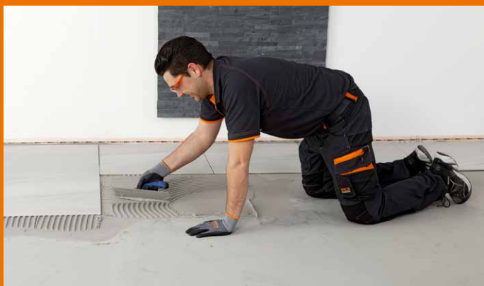
PCI Nanorapid bringt als neue Wunderwaffe Schubkraft auf zeitkritische Baustellen.
