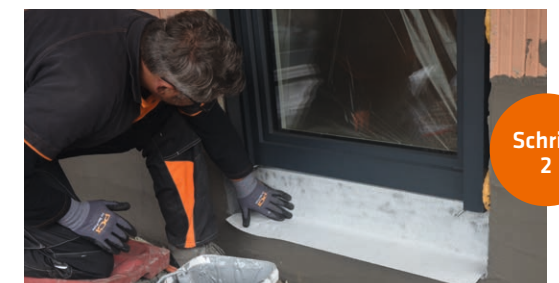
Das PCI Barraseal Ready Vlies vollständig in die noch frische Schicht PCI Barraseal Ready einlegen und vorsichtig andrücken.*
