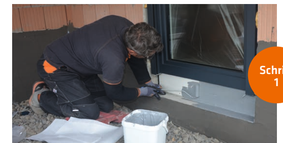
PCI Barraseal Ready mit einer kurzflorigen Rolle oder einem Pinsel flächendeckend auf den vorbereiteten Untergrund aufbringen.
