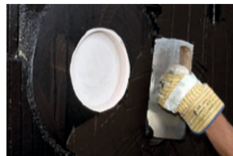
Anarbeiten von PCI Pecimor 2K an einen Klebeflansch
