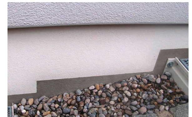
Bauwerksabdichtungen mit PCI Barraseal Turbo / PCI Barraseal Turbo 1K können im Sockelbereich so belassen oder überstrichen/überputzt werden
