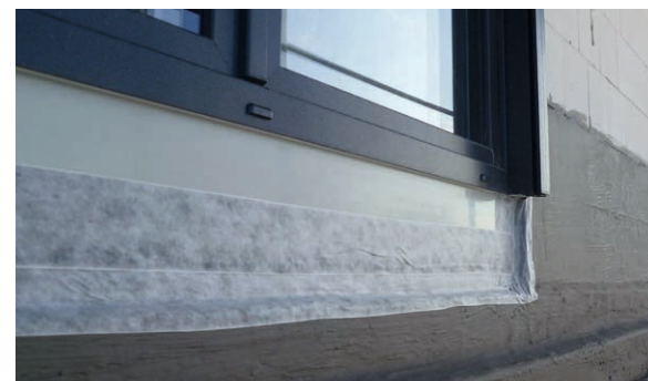
Anschluss Fensterelement mit Fixband PCI Pecithene Fix
