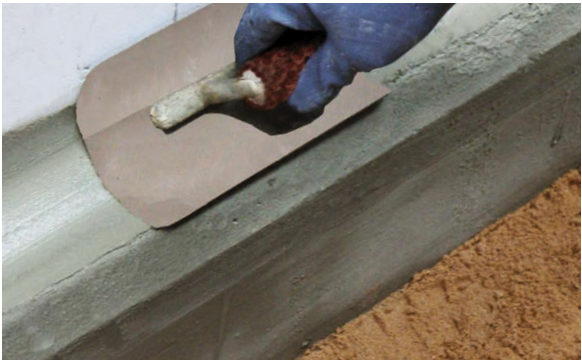
Erstellen einer wasserdichten Dichtungs-/Hohlkehle mit PCI Polyfix plus L
