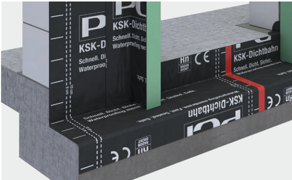
Grundabdichtung mit PCI Pecithene 1000 - bereits abgedichtetes Fensterdämmelement
