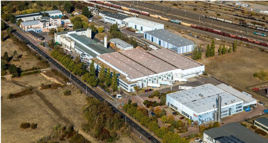
Der PCI-Standort Wittenberg ( Link zum hochauflösenden Photo)
