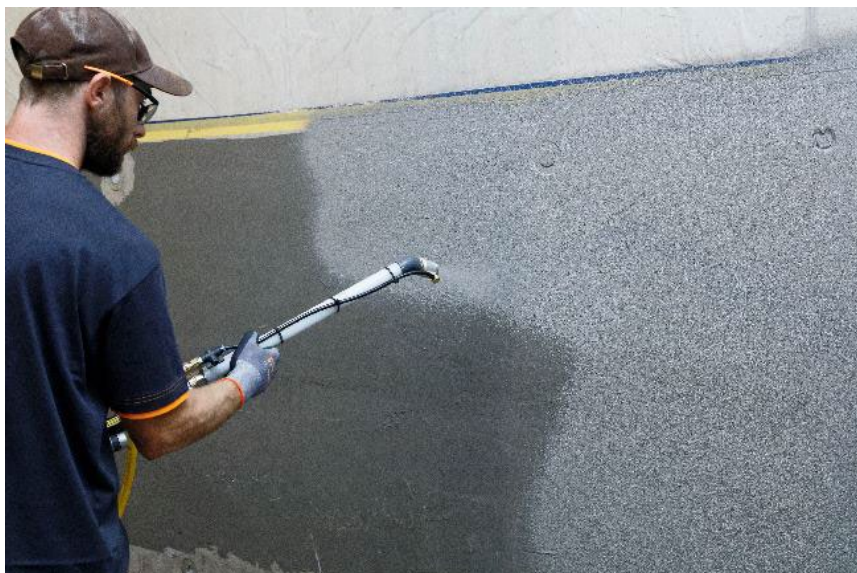
Verarbeitung PCI Barraseal Turbo 1K im Spritzverfahren ( Link zum hochauflösenden Photo)
