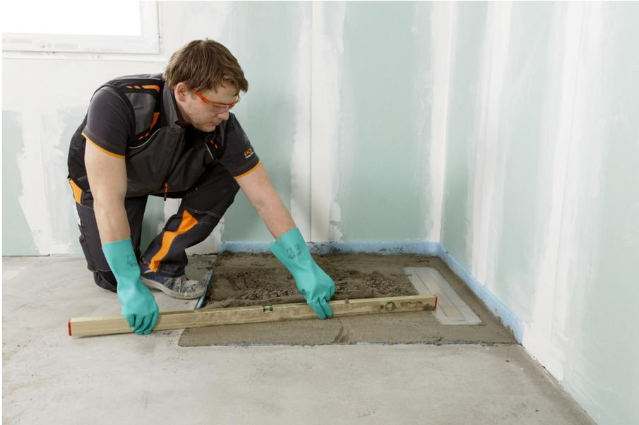
PCI Novoment Light punktet mit einfacher Verarbeitung: leichtes Aufziehen und Verdichten bei langer Verarbeitungszeit und kurzer Trocknungszeit für den schnellen Baufortschritt.
