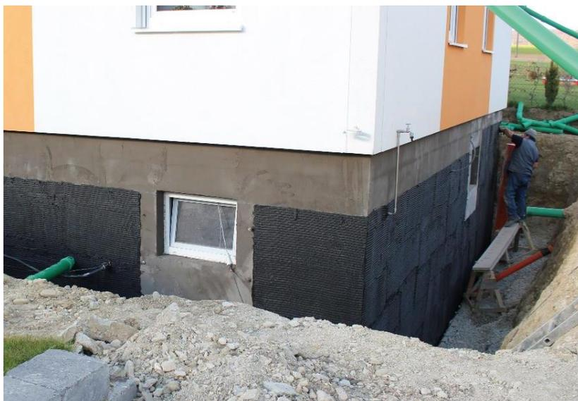
PCI-Systemlösungen für die effektive Bauwerksabdichtung gegen eindringende Feuchtigkeit (im Bild das MDS-System von PCI) ([Link](#) zum hochauflösenden Photo)
