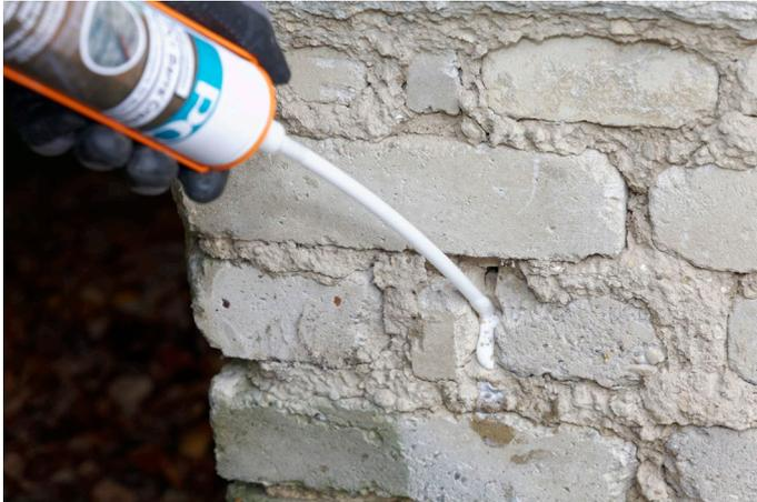
Das System PCI Barra ist eine sichere Lösung für die nachträgliche Innenabdichtung und Mauerwerkssanierung. PCI Barra Creme als eine der Systemkomponenten dient als Horizontalsperre gegen eindringende Feuchtigkeit. Die Injektion lässt sich einfach und drucklos ins Mauerwerk einbringen.
