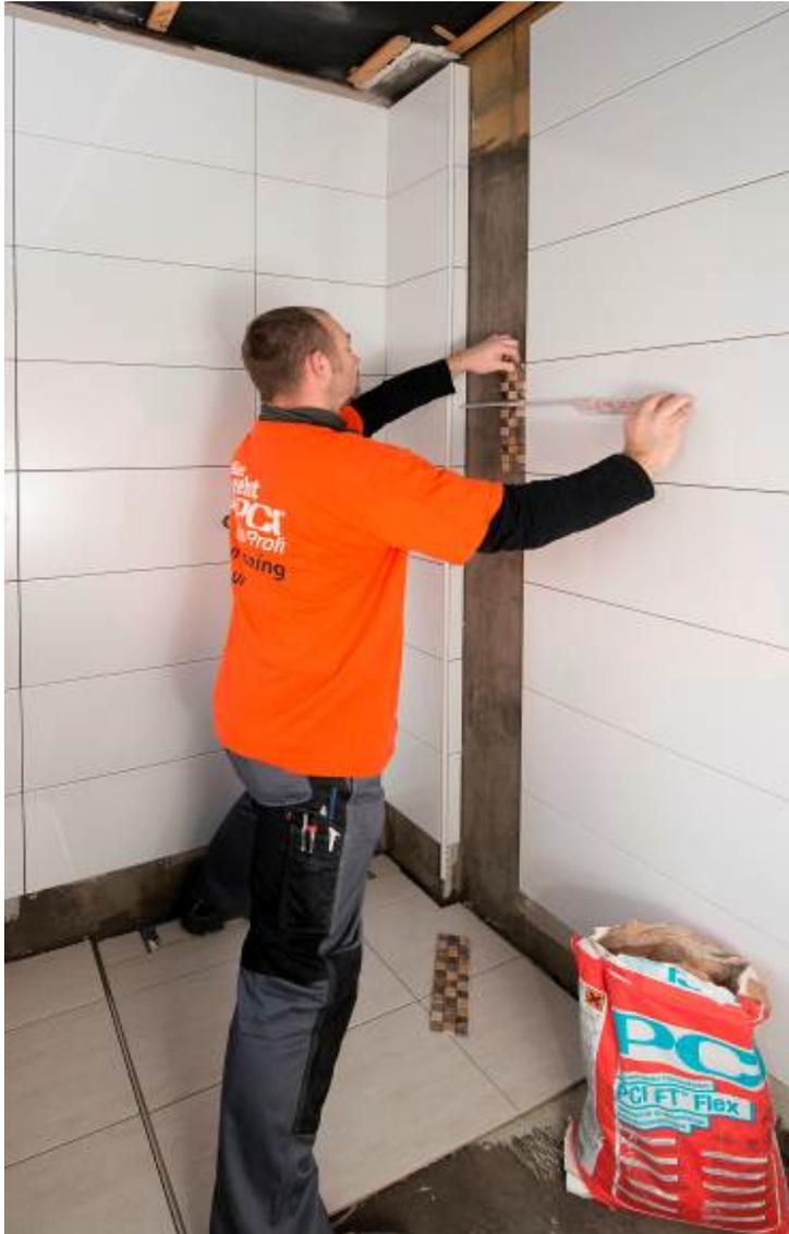
Damit die Nutzer lange Freude an ihrem neugestalteten Bad und den Belägen haben, kam im Moerser Badezimmer der flexibilisierte Fliesenkleber PCI FT Flex zum Einsatz. Der Mörtel ist der Spezialist für schwere, großformatige Platten, aber ebenso für kleinere Formate geeignet. Die optimierte Formulierung verhindert ein Abrutschen der Fliesen und sorgt so für die sichere Anbringung.
