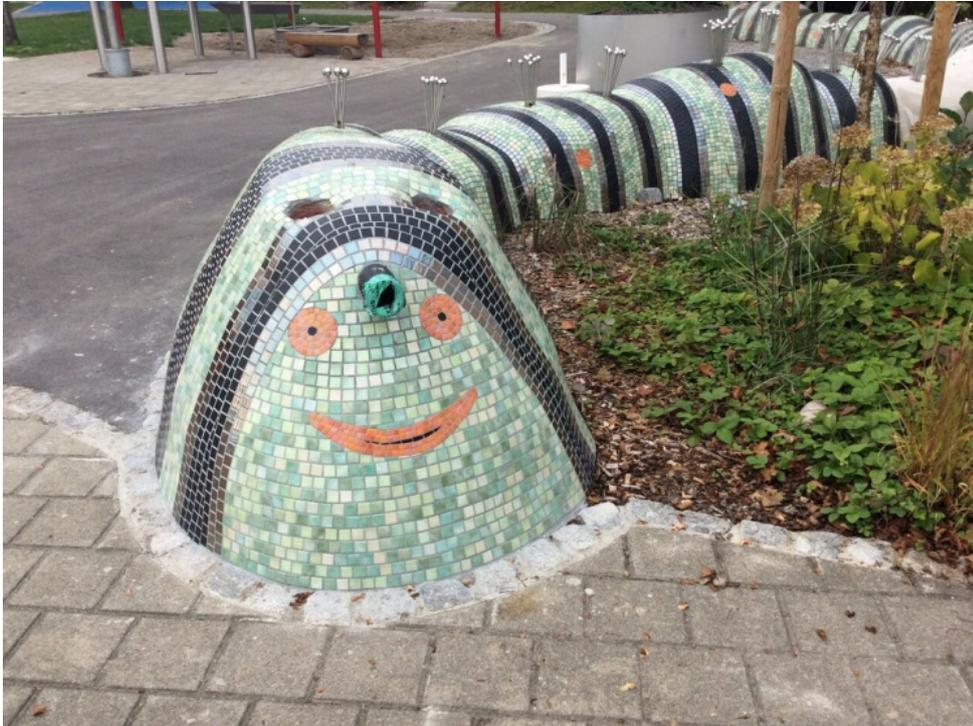
Für das Verfugen der Mosaik verwendete der Fliesenlegermeister den variablen Flexfugemörtel PCI Nanofug Premium, der wie auch der Ausgleichsmörtel und Fliesenkleber sehr emissionsarm ist nach GEV EMICODE EC 1 PLUS R.
