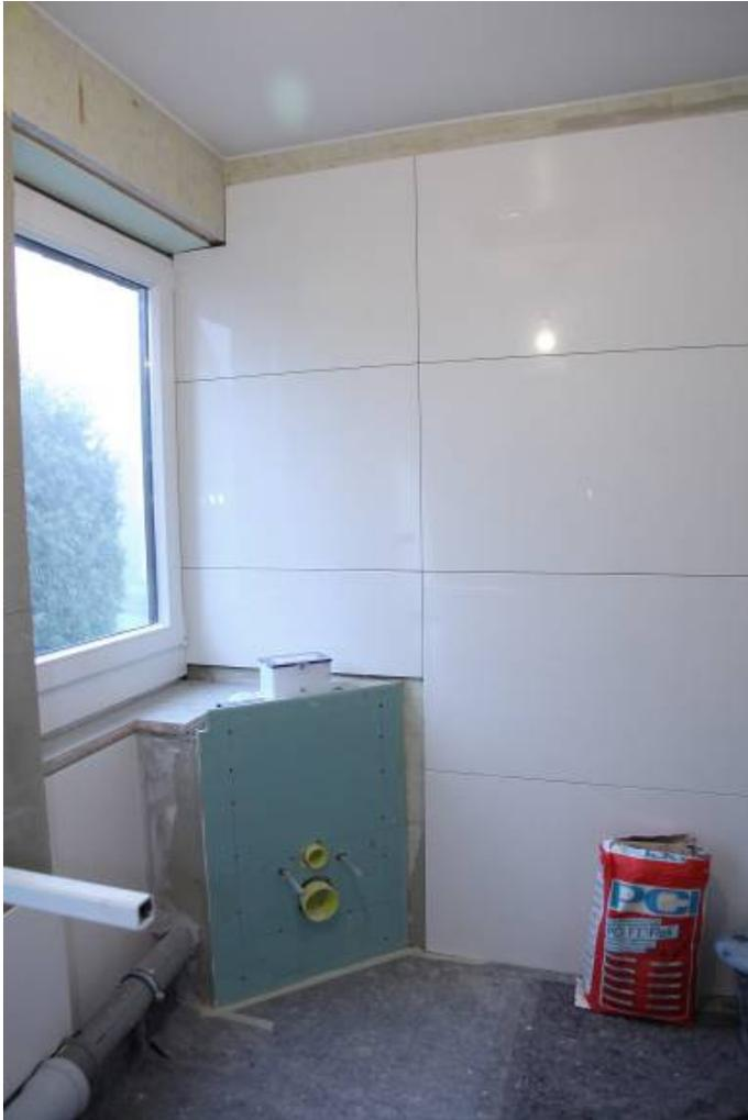
Mit dem flexibilisierten Fliesenkleber PCI FT Flex brachten die Bauprofis das großformatige Feinsteinzeug sicher an die Wand. Das Produkt bietet eine hohe Standfestigkeit und gleicht Spannungen in Folge von Temperaturschwankungen im Untergrund aus.
