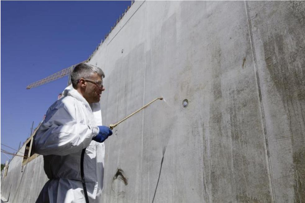
Zur Untergrundvorbereitung sprühten die Verarbeiter die Spezial-Grundierung PCI Pecimor Betongrund auf.
