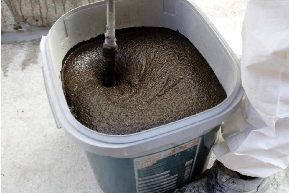
PCI Pecimor 2K lässt sich mit dem PCI Anker-Rührer problemlos zu einer homogenen Masse anrühren und einfach sowie kraftsparend verarbeiten.
