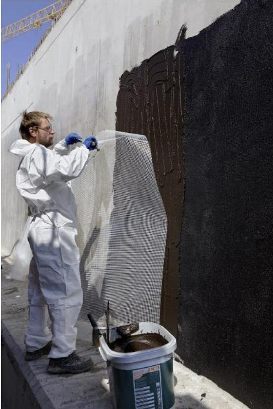
Die Abdichtung mit PCI Pecimor 2K erfolgt immer zweilagig – mit Kelle, Spachtel oder maschinell im Spritzverfahren. In die frisch aufgebrachte erste Schicht ist die PCI Gewebbahn mit 10 cm Stoßüberlappung einzuarbeiten. Nach Erhärtung der ersten Lage folgt der zweite Auftrag.
