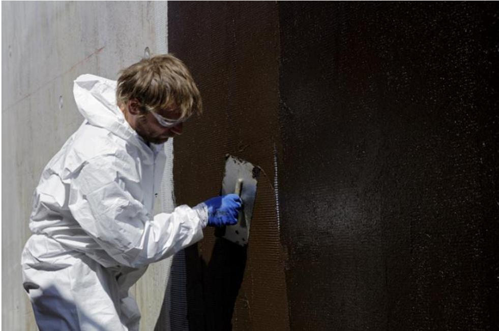
Auf den optimal vorbereiteten Untergrund folgte PCI Pecimor 2K. Die Bitumen-Dickbeschichtung erfüllt die Anforderungen nach DIN 18533-3 und ist geprüft nach EN 15814 und den Prüfgrundsätzen zur Erteilung des allgemeinen bauaufsichtlichen Prüfzeugnisses für Bauwerksabdichtungen im Übergang zu Bauteilen aus Beton mit hohem Wassereindringwiderstand.
