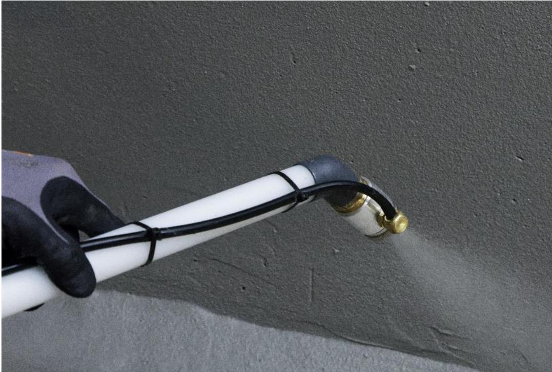
*Für die Abdichtung der Innenwände verwendeten die Verarbeiter PCI Barraseal Turbo. Die Reaktivabdichtung haftet sehr gut, bindet schnell ab und lässt sich einfach und schnell im Sprühverfahren auftragen.*
