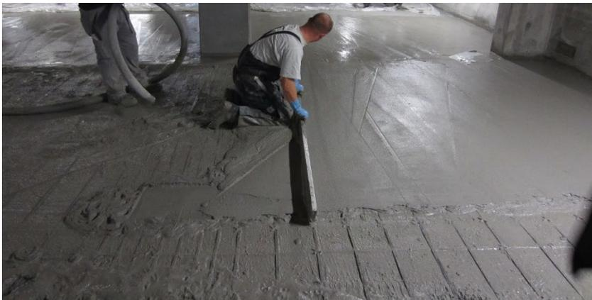
Der frische Mörtel wird in die noch frische Mörtelhaftbrücke «frisch in frisch» eingebaut. Dabei ist viel Aufmerksamkeit vom Verarbeiter gefordert. Weil bei diesem Prozess in das frische Mörtelbett das Anodennetz bzw. die Kabelbänder des KKS-Systems eingebettet werden. Durch das Anodennetz fließt später Strom, der für den Korrosionsschutz des Bewehrungsstahls gebraucht wird.
