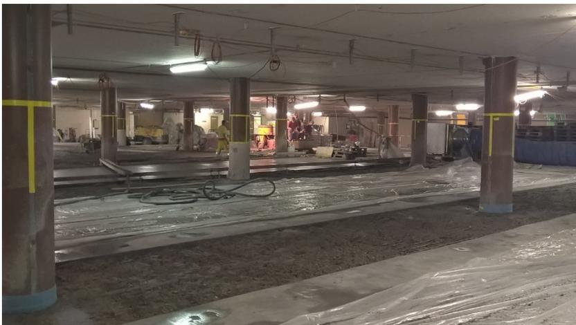
Mörtel mischen, pumpen, nivellieren und entsprechend der Vorgaben der Planer, die Oberfläche für die nachfolgende Parkdeckbeschichtung bearbeiten.
