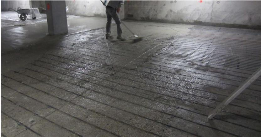
Gut zu sehen sind die Anodenbänder die in Streifen auf dem zu beschichteten Boden fixiert wurden. Auf den mattfeuchten Untergrund wird eine Haftbrücke aus Eigenmaterial des Betoninstandsetzungsmörtels PCI Nanocret R4 SA aufgetragen. Anschliessend wird der frische Mörtel in die noch frische Mörtelhaftbrücke «frisch in frisch» eingebaut.
