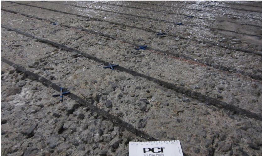
Die Anodenbänder werden nach Vorgaben des Planers auf den mit Wasserhöchstdruckstrahlen vorbereitenden Betonuntergrund verlegt und mechanisch fixiert.
